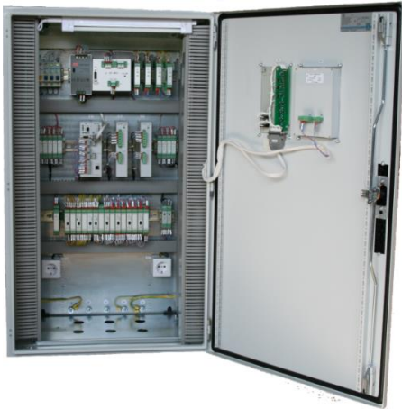
Шкаф управления ЦТП
