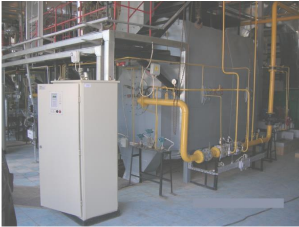
Типовой шкаф КШУ-ДЕ-25 на объекте с газовым оборудованием фирмы "Термобрест".
