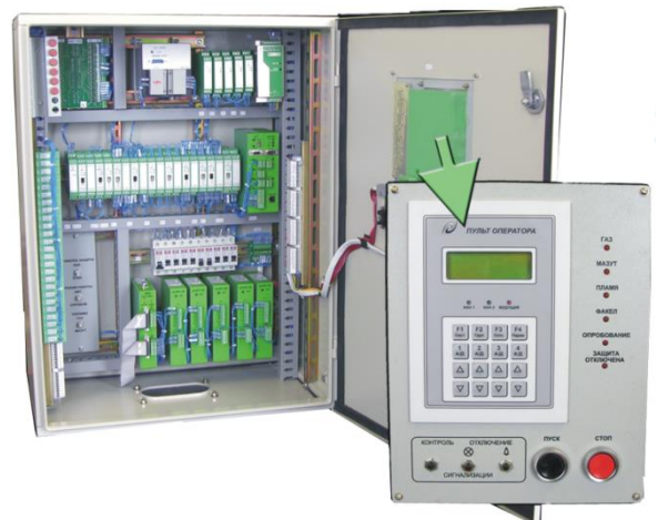
Пример исполнения шкафа КШУ-ДЕ-КВГМ на контроллере КР-500 М
